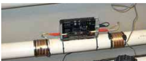
Vulcan 5000 sur la ligne de skimmer de la piscine principale
