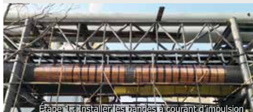
Étape 1 : Installer les bandes à courant d'impulsion
