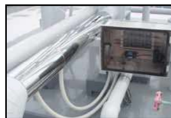
Installation de câbles et le S25 Vulcan dans la boîte.
