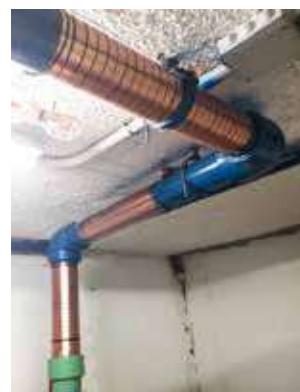
Étape 1 : Installer les bandes à courant d'impulsion
