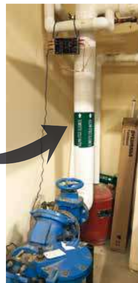
Étape 2 : Installer l'unité S25 sur la conduite d'eau principale et remettre la couche isolante
