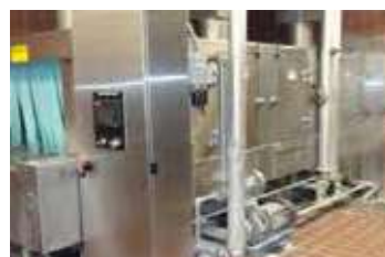
Convoyeur rondelle de vapeur
