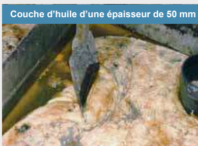
Filtre à graisse
