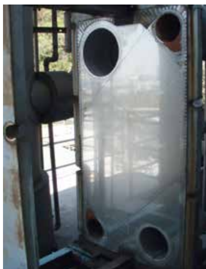
9 mois après l'installation de Vulcan : l'échangeur à plaques est propre et prêt à l'emploi.
