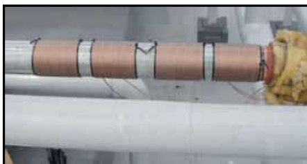
Enroulement de câble terminé.
