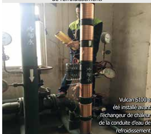
Vulcan S25 a été installé avant l'échangeur de chaleur de la conduite d'eau de refroidissement.
