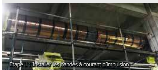
Étape 1 : Installer les bandes à courant d'impulsion
